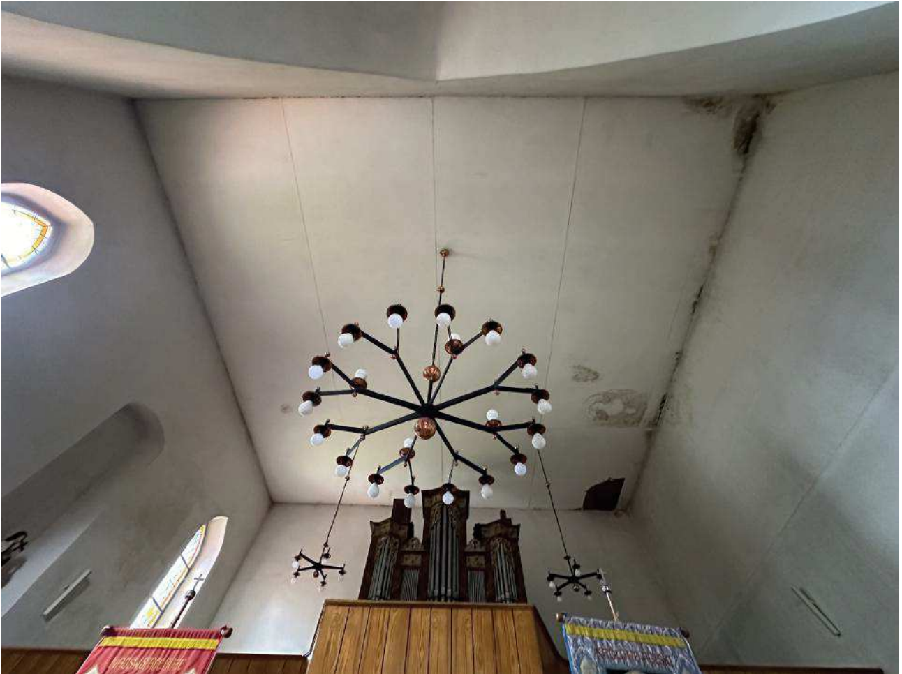
STROP NAD NAWĄ
