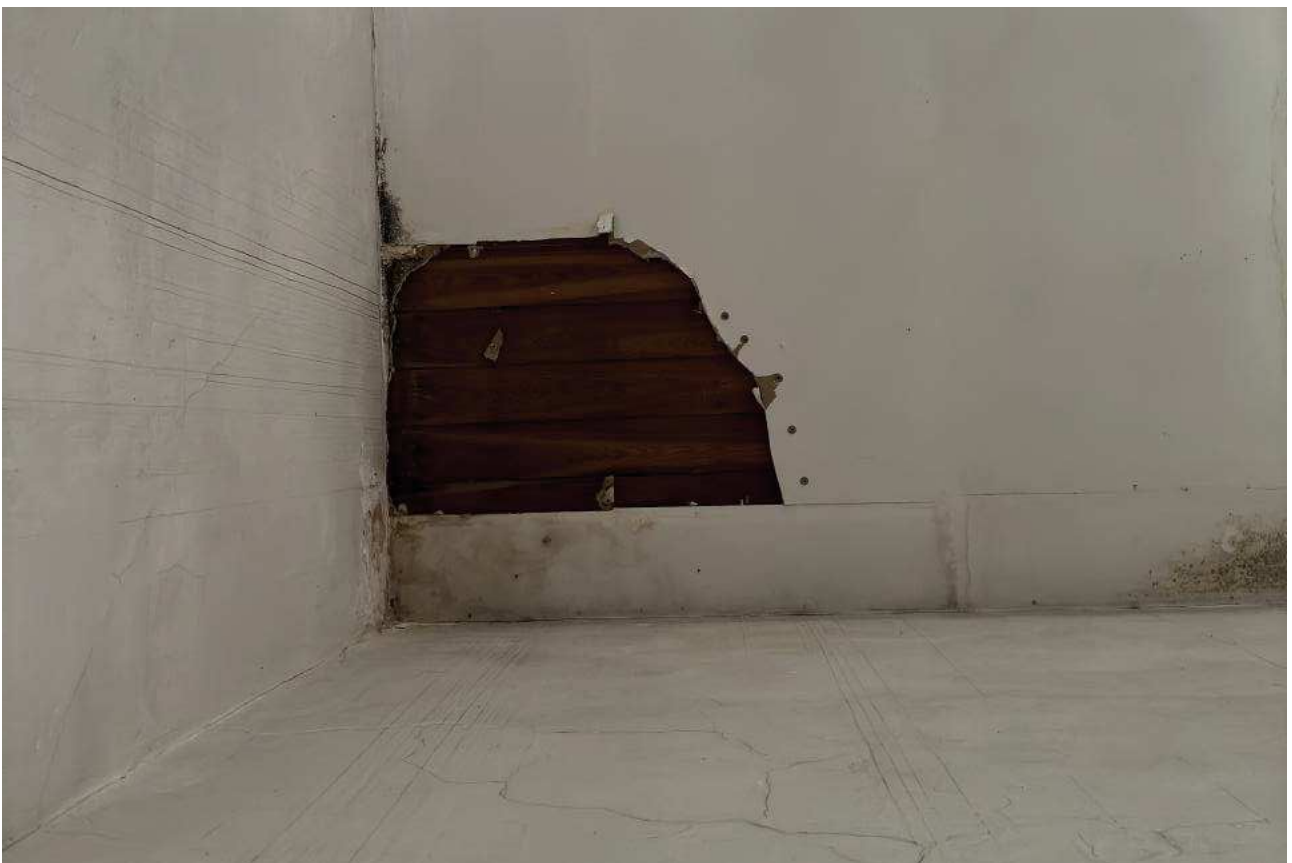
ODKRYWKA POKAZUJĄCA DESKOWANIE STROPU
